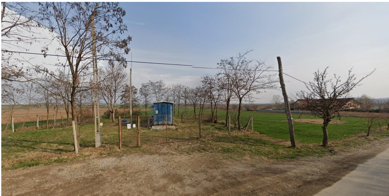
Fotografia 1 – Vedere către stația de tratare apă din drumul județean DJ119. Sursa: Google Earth
